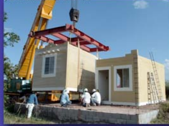
Traslado de los módulos a su destino final
