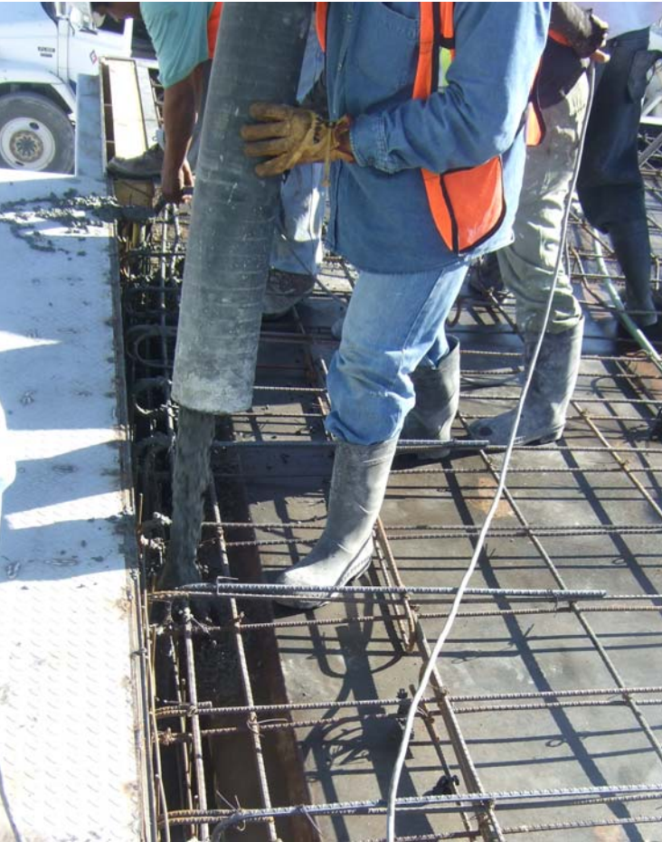
Moldeo en exterior utilizando camión revolvedora y bomba tradicional
