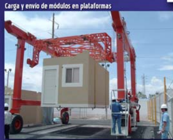
Maniobra para colocación de los módulos y conexión de las instalaciones
