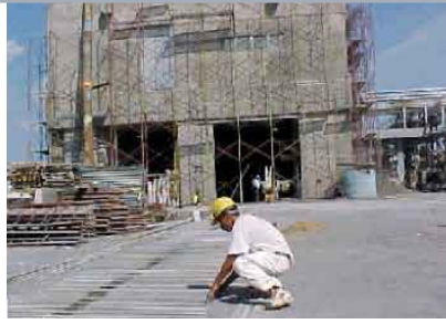
Silos de Apasco (2000).
