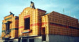
MOLDES ACERO O ALUMINIO. Son sistemas de cimbras metálicas que encofran al 100% el concreto de una vivienda: muros, losas, escaleras, pretilles, etc que permite colados monólicos y producen una, dos tres, cuatro viviendas por día.
