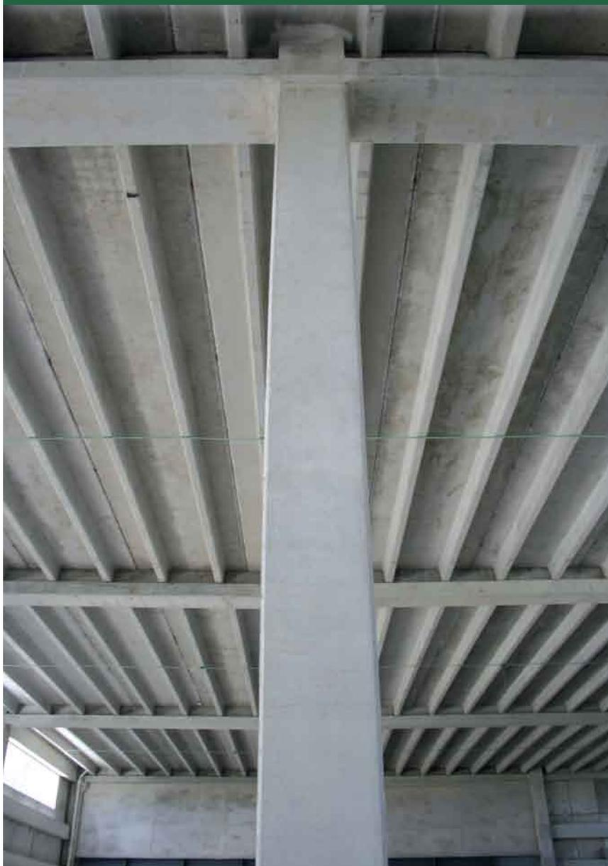
con concreto ciclópeo en roca- y rematando con losas doble T con una capa de compresión, desde la base hasta la cubierta, la obra de las Bodegas del Ejido está construida con elementos prefabricados elaborados en Mérida por Prefabricados de Concreto, S de RL (PREDECON).
