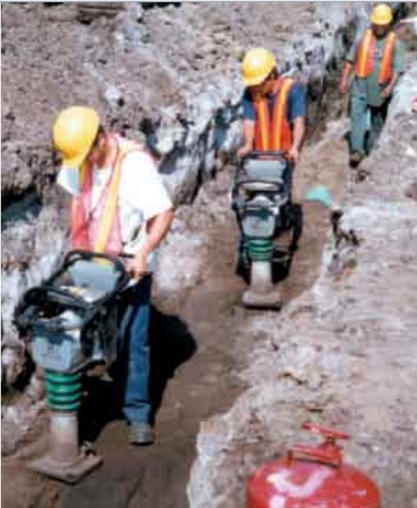
**Una apisonadora propulsada por gasolina puede compactar tanto el suelo cohesivo como el suelo mixto. Las apisonadoras están diseñadas para usarse en zanjas, alrededor de muros de contención, y para solidificar bases para losas de concreto, carreteras y columnas para puentes.**
