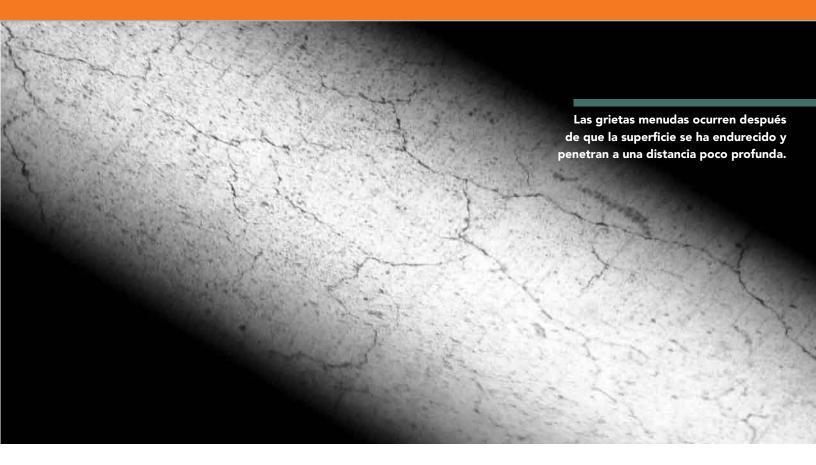
raras en superficies acabadas, especialmente cuando se usa concreto de alta resistencia temprana. A veces son difíciles de ver y con frecuencia sólo aparecen después del mojado y el secado. No obstante, existen procedimientos que pueden minimizar el riesgo de agrietamiento menudo. Se pueden ajustar las condiciones ambientales, los procedimientos de acabado, y la aplicación del curado.
