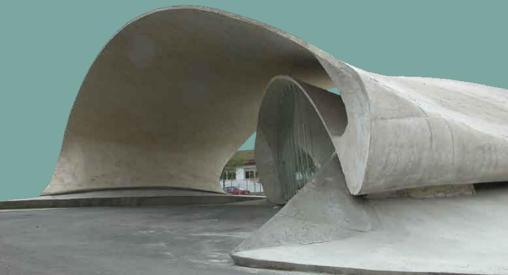
“Pensamos que teniéndolos tan cerca podíamos generar una arquitectura que no fuera indiferente a su mundo y empezamos a trabajar en una forma que consiguiera naturalidad y funcionamiento. A partir de ahí el concreto, material con el cual trabajaríamos, debería ser transformado en una lámina que se pliega sobre sí misma para albergar todo el programa de necesidades dentro de un cuerpo más que escultórico”.
