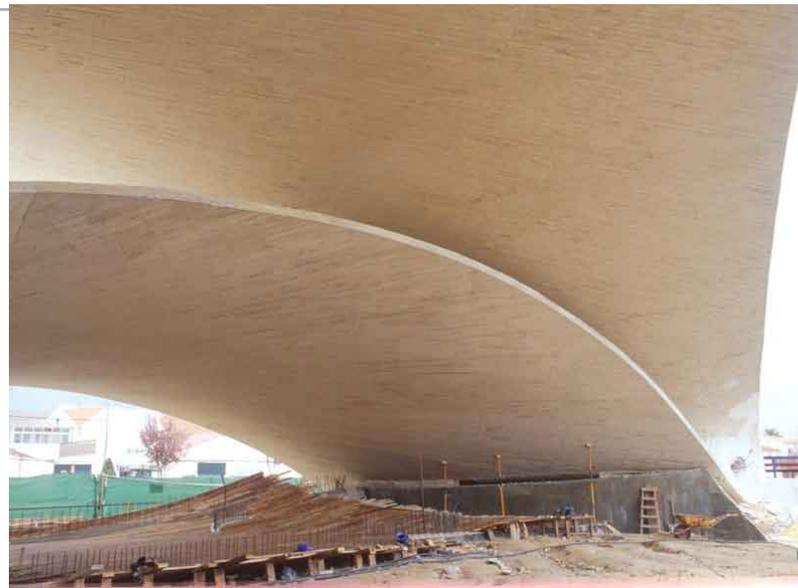
de cabeza de anclaje perdida en cimentación y tensamos desde la cara superior. De este modo se pre-comprime la sección de concreto convirtiendo las tensiones en meras descompresiones que no provocan ni deformaciones ni elongaciones que pudieran modificar el perfil geométrico proyectado”, explica el dr. Jaime Cervera Bravo, encargado del área estructural del despacho del arq. García Rubio.
