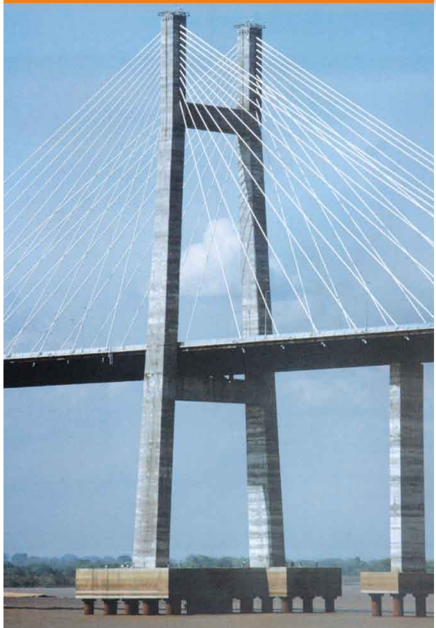
Foto: Cortesía del libro "La construcción de un hito de ingeniería sudamericana".
