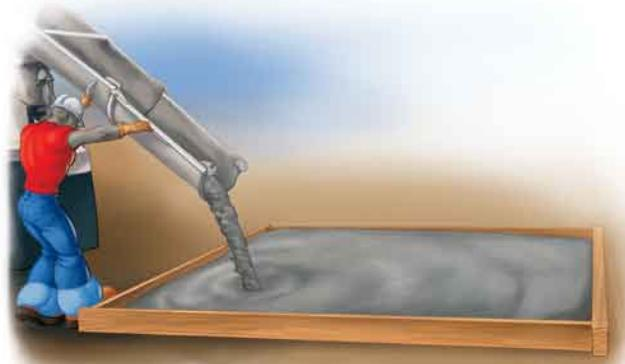
1. Puede colocarse a un ritmo más rápido sin vibración mecánica y menos enrase, dando como resultado ahorros en los costos de colocación.
