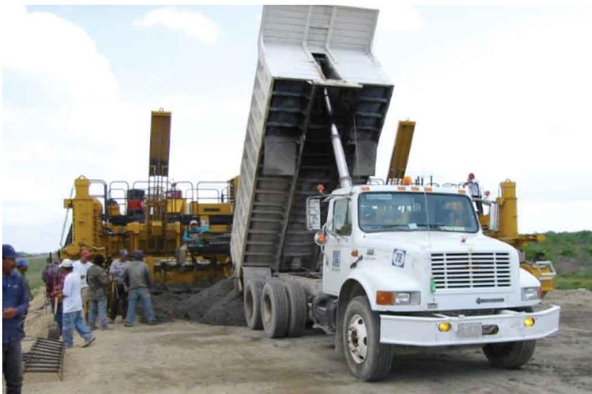
mezclas se elaboran con revenimientos bajos, entre 3 y 5 cm., para evitar que se "caigan" las partes laterales de la carpeta (hombros). El otro aditivo es un inclusor de aire (ASTM C-260), el cual brinda movimiento microscópico al concreto estático, evitando que éste se adhiera a las paredes de las cajas de los transportes. Adicionalmente, evita la fisuración del concreto por efectos de la congelación y deshielo.
