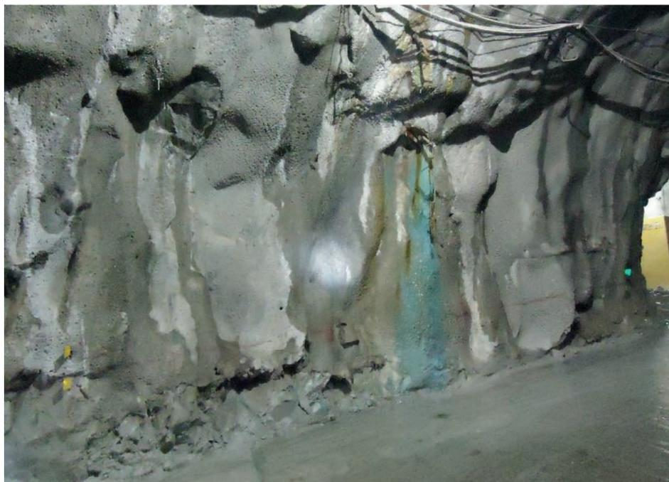
**Figura 1. Ataque químico al concreto lanzado en túnel de minería.**
