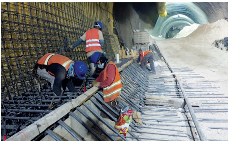
**Figura 3. Armado de estructura de acero de hastiales previo a su colado.**
