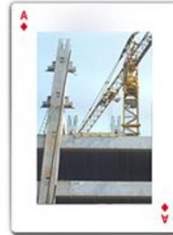
Edificios de más de siete niveles, resueltos con elementos prefabricados de concreto y columnas segmentadas, diseñados de acuerdo con el Reglamento de Construcciones de la ciudad de México de 1987 y actual.
