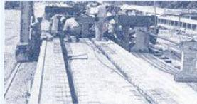
La soldadura por resistencia eléctrica de la malla de ingeniería que se usa para refuerzo de concreto permite reducir el acero en los traslapes y en los anclajes e incrementar la velocidad de ejecución de la obra, al acortar los tiempos de habilitado, armado y colocación en 70 por ciento.
