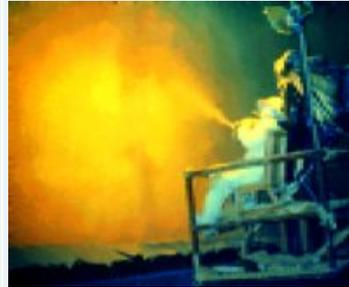
Si la mezcla que se va a lanzar cuenta sólo con agregados finos, se le llama mortero lanzado, y si los agregados son gruesos se le denomina concreto lanzado. Por otra parte, el concreto con agregado fino es conocido como gunite, y cuando incluye agregado grueso, como shotcrete, aunque también se llama gunite al concreto lanzado por la vía seca, y shotcrete al concreto lanzado por la vía húmeda. .
