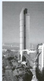
disipadores de energía para amortiguar los desplazamientos ocasionados por los sismos, y una losa de cimentación de 2.80 m de espesor para soportar y dar estabilidad a la estructura.
