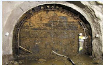
La construcción de una galería subterránea de 230 m de longitud permitirá a los habitantes de la antigua ciudad francesa minera de Moyeuve tener los pies secos de una vez por todas. El objetivo es bajar cinco metros el nivel freático, extrayendo el agua por gravedad mediante una canalización de achicamiento que desembocará a 450 metros, en el río Orne.
