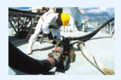
Además, soporta altas vibraciones, desde baja a alta fluidez sólo con aumentar la cantidad de agua a la mezcla. Su aguante a la compresión es de 500 a 800 kg/cm2, de 1 a 28 días. Y preferentemente la mezcla se debe hacer con equipo mecánico, pues tiene una elevada resistencia mecánica.
