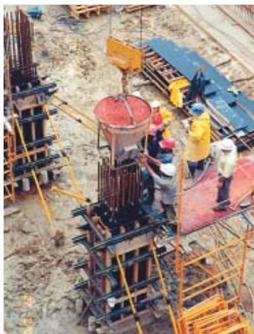
Fig. 5: Una grúa y un cucharón o tolva de volteo colocan el HPCC dentro de las cimbras de las columnas
