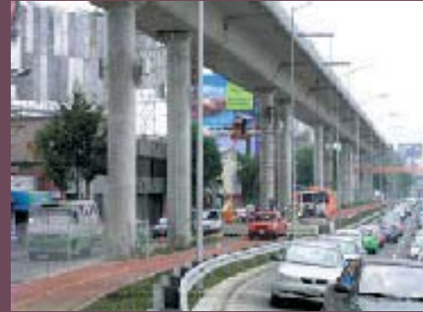
Figura 2 Vista general de la estructura
