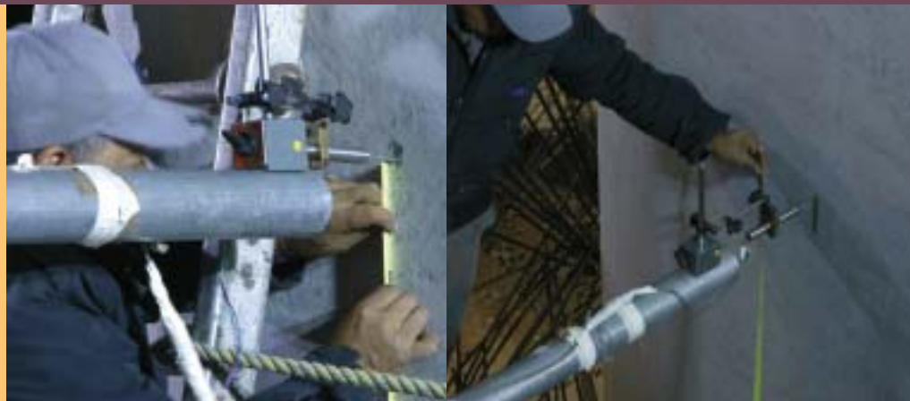
Determinación de la ubicación de los trasductores de desplazamiento para medir la deformación lateral de la columna debido al jalón producido por la grúa de 500 ton.
