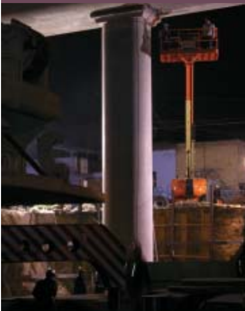
Colocación de la marcas de referencia topográfica en el fuste de la columna
