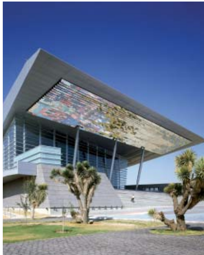
Auditorio Gota de Plata, obra ganadora de las categorías Construcción y Diseño de Edificación Internacional
