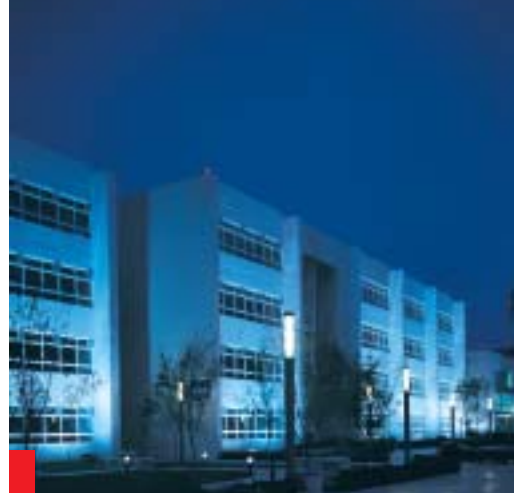
UNITEC Campus Zapopan, obra ganadora del Premio Especial en Arquitectura Sustentable
