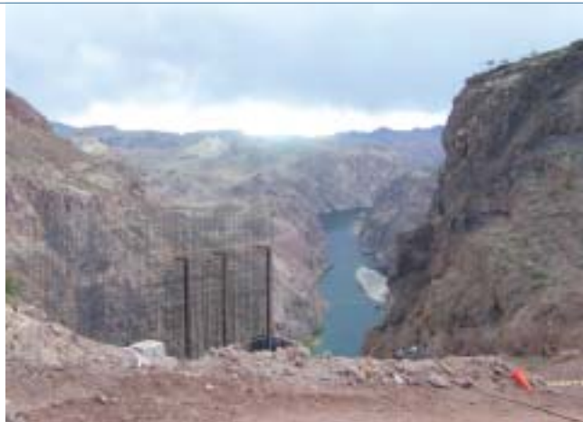
El By-Pass culminará su construcción a mediados de 2008.
