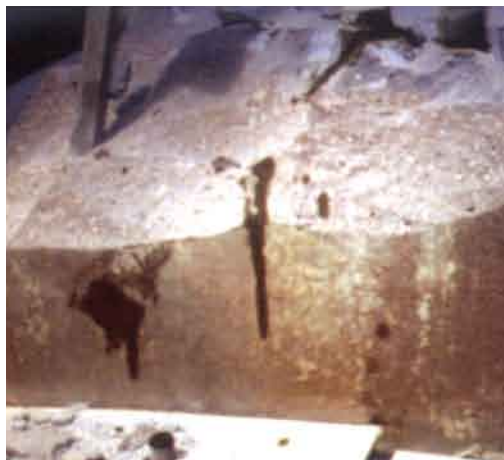
Fig. 4: Durante la reparación del cimient, tuvo que removerse la gruesa lechada epóxica.
