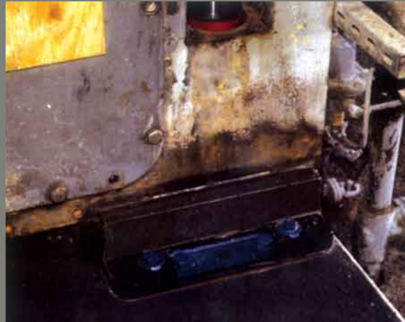
Fig. 6: Calza epóxica ajustable completada en un perno de anclaje en el cimiento de reparación.
