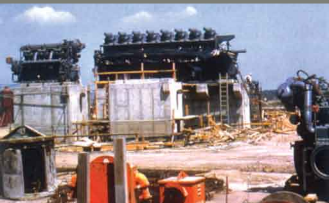
Fig. 2: Instalación original del cimient en 1963.
