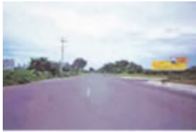
Tramo La Flecha La Herradura , en El Salvador, construido en 1953 utilizando base de suelo-cemento.
