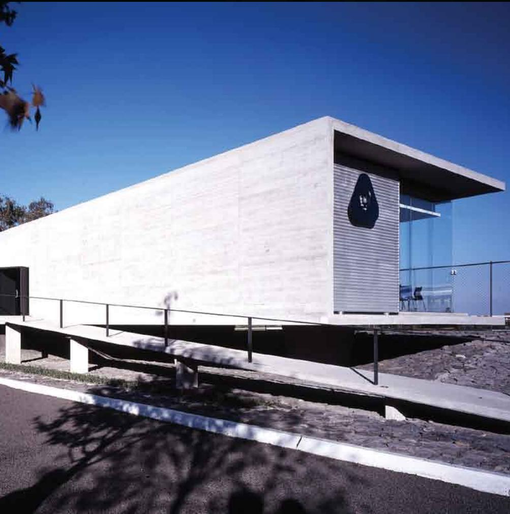
sentido longitudinal que apoyan la losa reticular aligerada y en el sentido transversal trabajan como muros de cortante que proporcionan la rigidez necesaria al edificio”.
