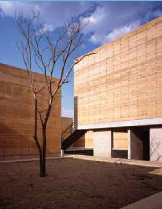
Escuela de Artes Plásticas de Oaxaca, diseñada por el arq. Mauricio Rocha y equipo, ganadora en el rubro de Diseño de Edificación Institucional.
