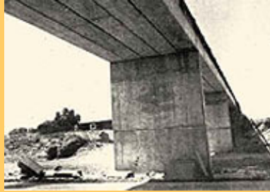
Solución con vigas TIB. Paso en el km 169.
