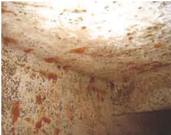
La acción física se produce si hay humedecimientos y secados sucesivos, produciéndose presiones de cristalización de los sulfatos, provocando con su consiguiente aumento de volumen, desintegraciones en el concreto similares a las producidas por los ciclos de congelamiento y deshielo.
