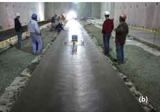
Fig. 2. Equipos para desarrollar perfiles de pisos: A. Perfiladora de espaciamientos para mediciones de 300 mm para evaluar la planicidad y nivelación de pisos ( F_F y F_L ) para tráfico aleatorio. B. Perfilógrafo diferencial de eje dual para evaluar la nivelación y la planicidad de un piso (F-min) para tráfico definido. Nótese que las losas para pisos de tráfico definido son colocadas en franjas angostas (no más anchas que 6 m) para controlar las tolerancias. También están densamente reforzadas y no deben tener ninguna junta perpendicular a la ruta definida del vehículo. Los mecanismos de transferencia de carga deben usarse para estabilizar las losas entre las juntas de construcción longitudinales.
