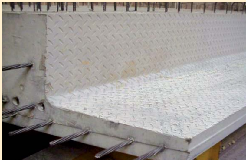
Fig. 4 Calidad superficial de una pieza elaborada con CAC.
