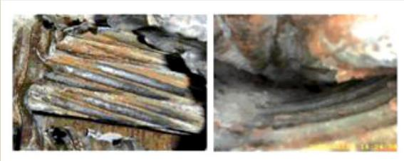
Sección de ducto de postensado sin grout.
