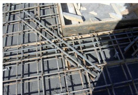
Reforzamiento adicional en zona de vano de ventana de un muro Tilt-up.
