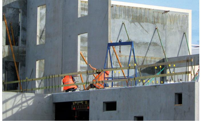
Es importante señalar que la posición y número de insertos se dará en función del proceso de montaje y de las acciones a las cuales estará sometido el muro durante la etapa de apuntalamiento.
