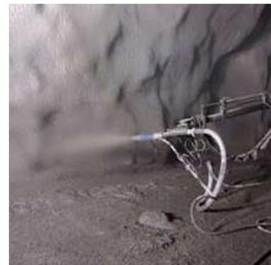
**EL CONCRETO lanzado es, a decir del la Norma ACI 506 R, "un mortero o concreto lanzado neumáticamente a una gran velocidad contra una superficie".**
