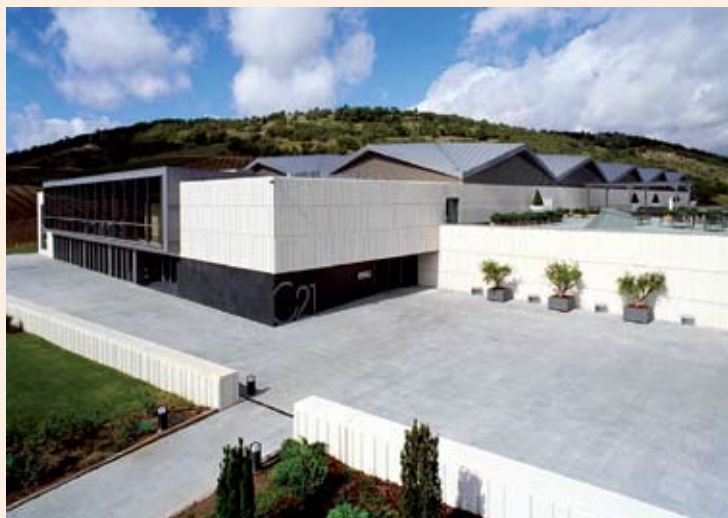
Fig. 2: Las fachadas y los pavimentos son dos buenos ejemplos de las ilimitadas posibilidades arquitectónicas que ofrece la construcción con elementos prefabricados de concreto.
