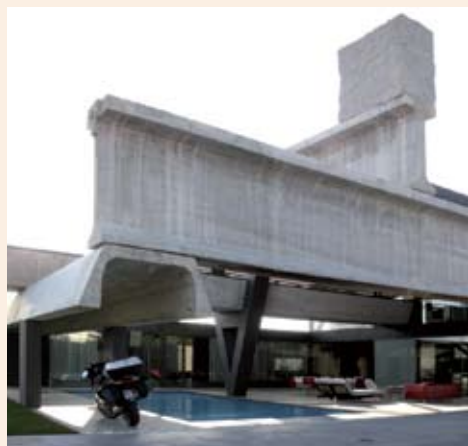
Fig.3: Casa Hemeroscopium, del arquitecto Antón García Abril. Uso de elementos prefabricados habituales en la construcción de puentes, en una aplicación residencial.
