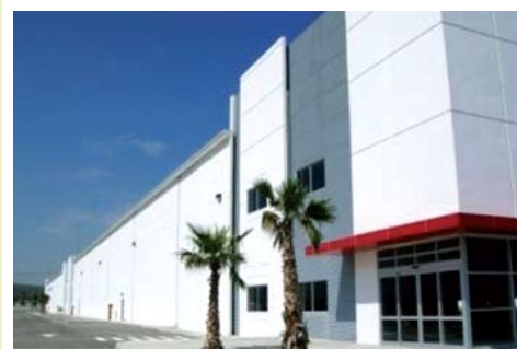
Nave industrial construida con "Tilt Up".
