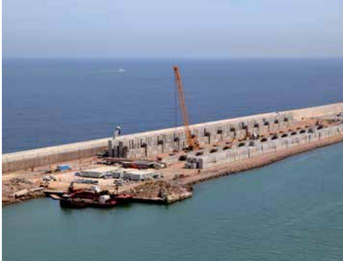
las 5 horas. Su suministro se realiza mediante dos plantas de obra, cada una con capacidad de 1,100 m<sup>3</sup> por día. El volumen total de la obra es de 200,000 m<sup>3</sup> de concreto.
