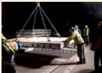
Pavimentos prefabricados, (Cortesía Dr. Shiraz Tayabji, Enero 2012).
