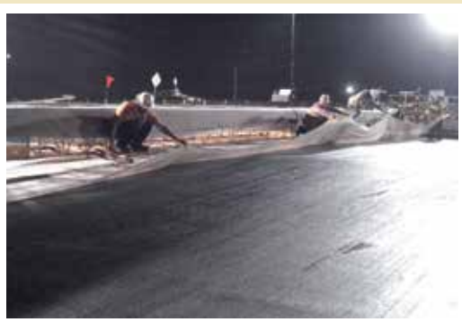
Curado del piso de concreto luego de aplicar endurecedor
