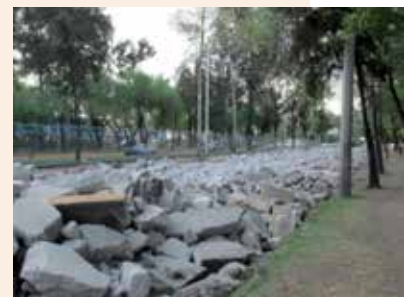
Concretos reciclados, México, D.F. 2013.
