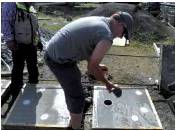
Ing. Marc Jolin Revisando los núcleos de concreto.
