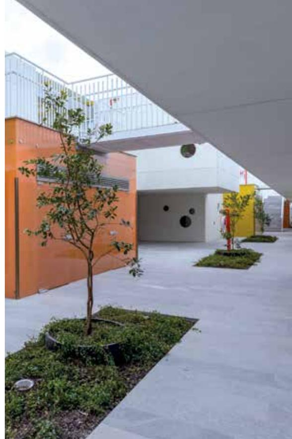
La estructura del edificio es una armadura vierendeel, conformada por ejes estructurales ortogonales, que trabaja como una gran trabe, lo cual facilitó librar grandes claros y diseñar los espacios a partir del módulo de la estructura. Las aulas están colocadas a lo largo de la armadura de manera aleatoria, como si fuesen los cubos de un juego de niños. Los volúmenes
