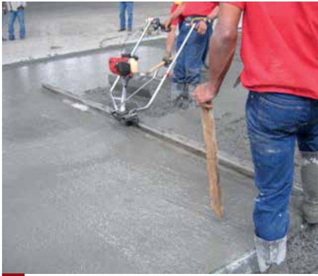
Vibración de correo con herramientas mecánicas.
