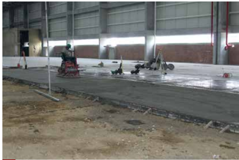
Acabado de losas de concreto mediante herramientas de tipo helicóptero.
