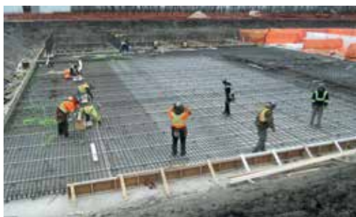
Construcción de los estanques de almacenaje de la Planta de agua.
