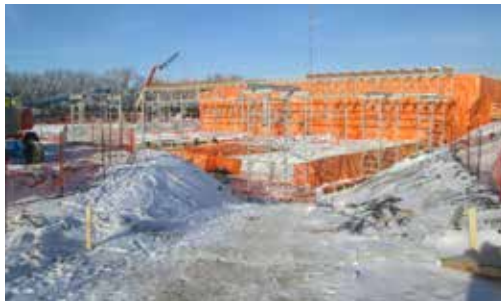
Instalación de la estructura temporal durante el invierno, Planta de agua.
