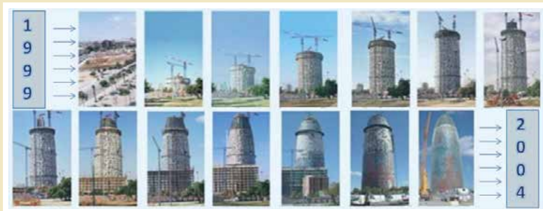
Secuencia de construcción de la Torre Agbar.
