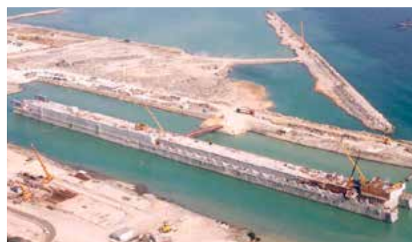
Proceso de construcción del dique.
