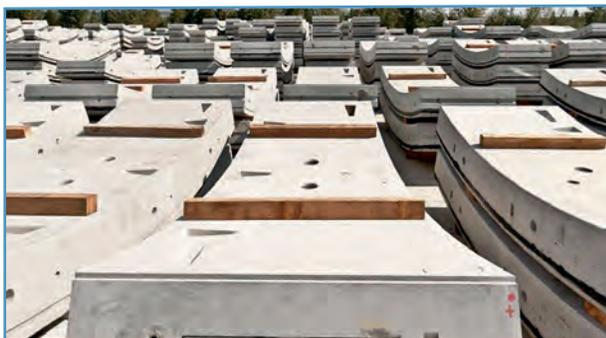
➤ *Secciones prefabricadas de concreto usadas para la construcción del nuevo túnel.*
