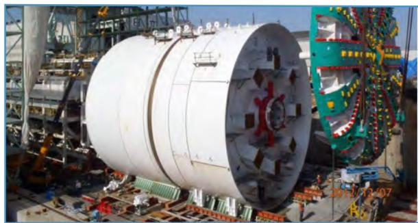
➤ *Ensamble y montaje de la tuneladora Bertha.*
