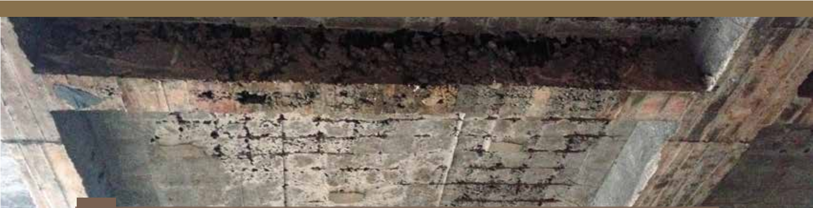
Aceros a la vista como consecuencia de un inadecuado recubrimiento de concreto. CORTESÍA SERVICIO INTEGRAL DE INGENIERÍA S.A.S
