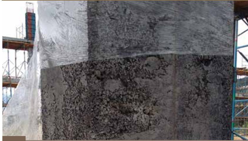
Hormigueros en una columna. CORTESÍA SERVICIO INTEGRAL DE INGENIERÍA S.A.S
