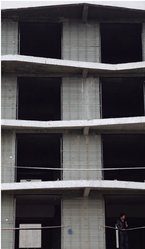
➤ Con el método de impresión 3D se construyó un edificio de apartamentos de cinco pisos. Cortesía: 3D Print – Brittney Severson.
