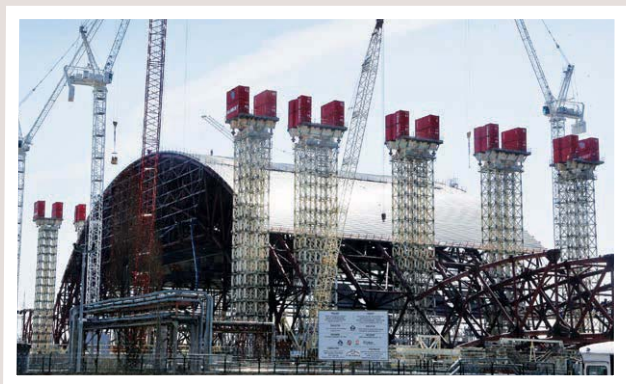
Inicio ensamblaje del arco.
