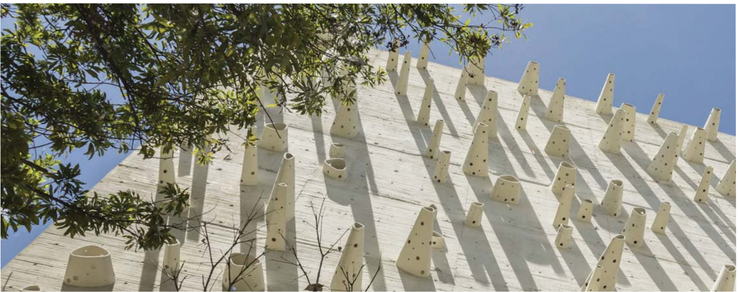
Fachada oriental del Centro Argos para la Innovación.
