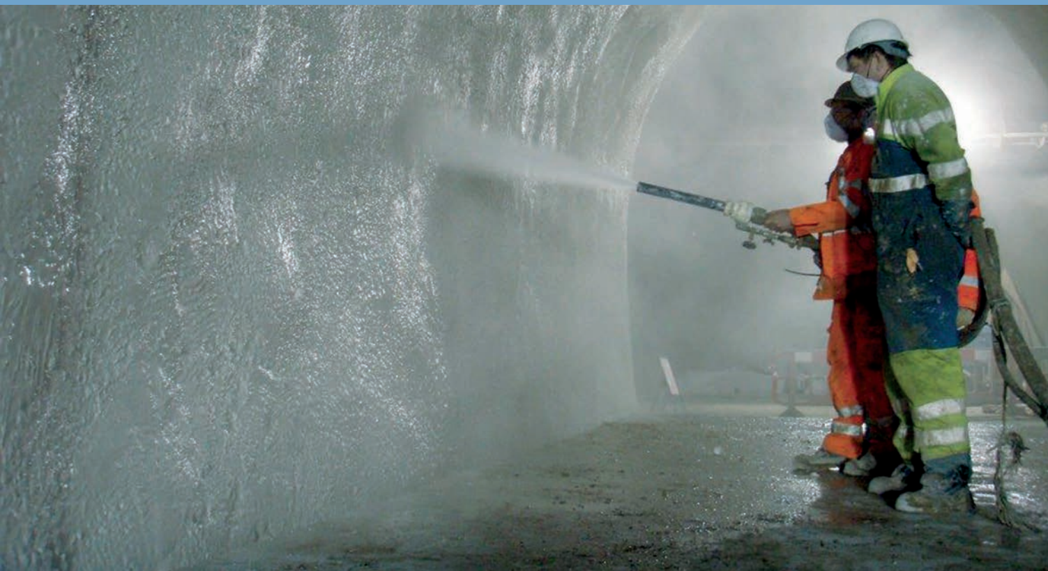
➤ Aplicación manual de membrana proyectada en el hastial de un túnel.
