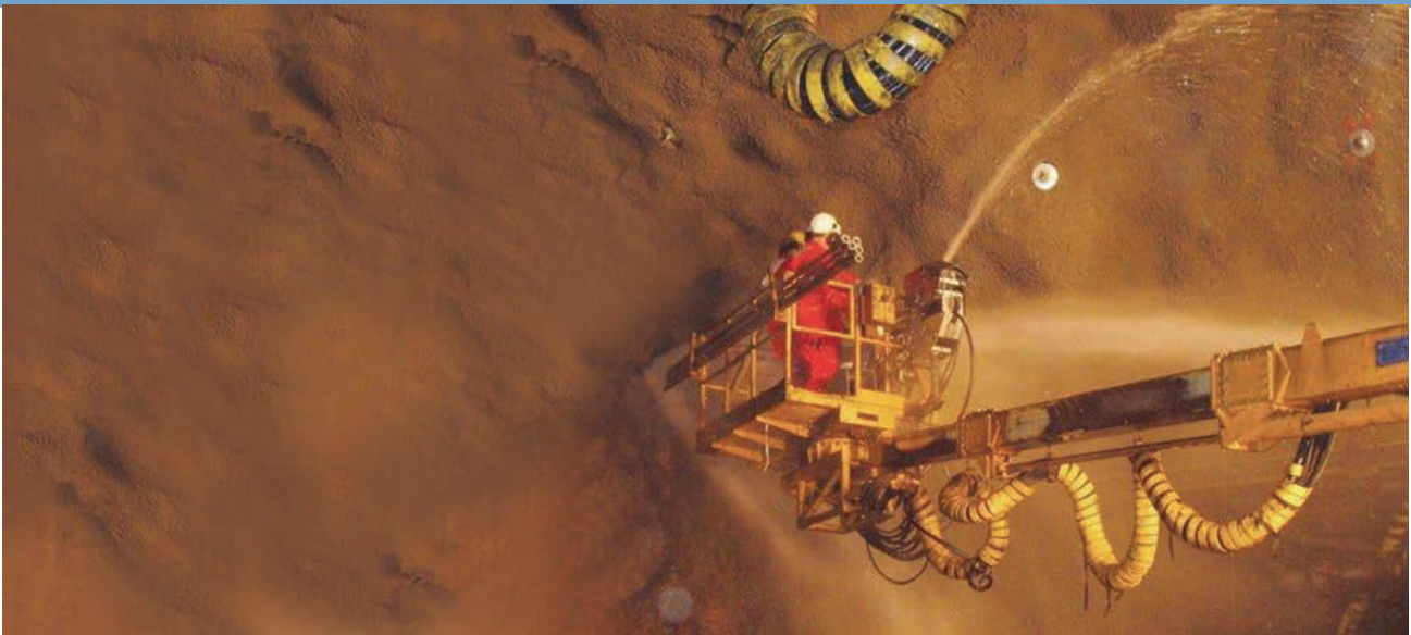
➤ Aplicación robotizada de membrana proyectada en la clave de un túnel.
