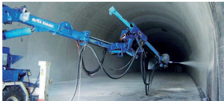
➤ Aplicación robotizada de membrana proyectada en el hastial de un túnel.
