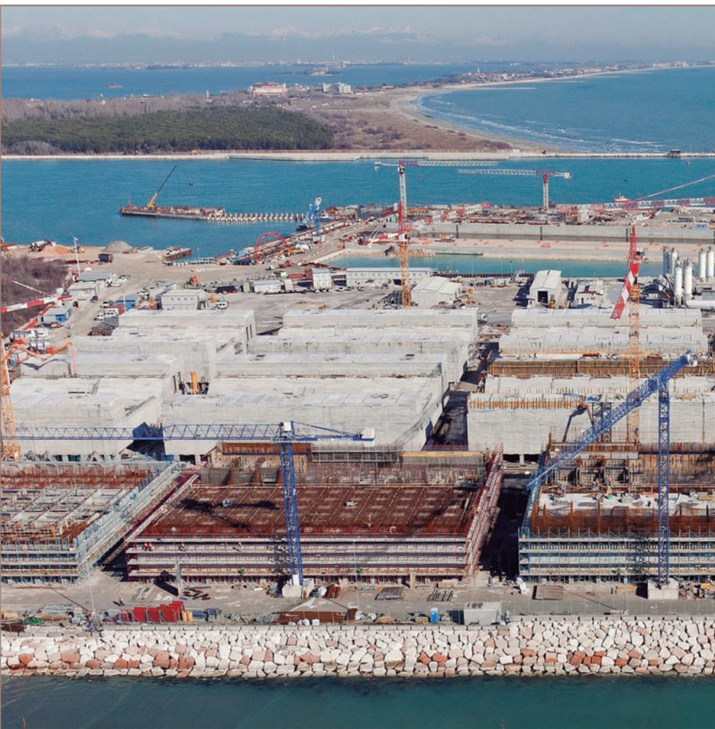
➤ Construcción de las estructuras cajón que soportan las compuertas de acero. CORTESÍA COMANSA
