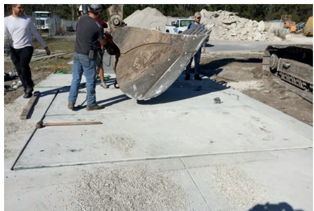
➤ Paso 2: Instalación de paneles prefabricados temporales de reemplazo en las secciones abiertas.
