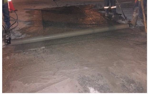
➤ Paso 7: Terminación de la superficie usando rodillo largo.
