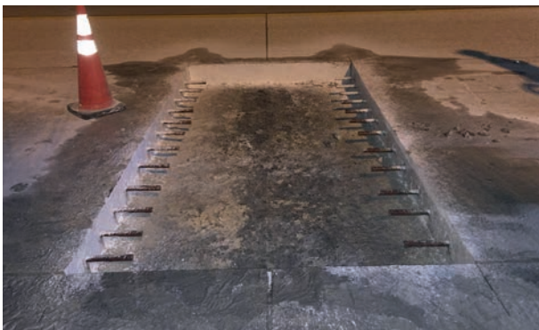
➤ Paso 5: Instalar las barras para las dovelas antes de fabricar los paneles de reemplazo.
