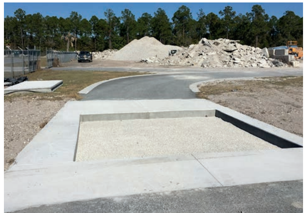
➤ Paso 1: Preparación de la sección de reemplazo.
