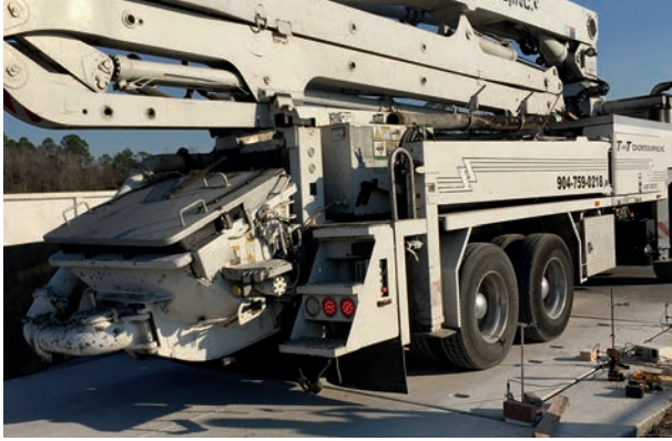
➤ Paso 3: Permitir el tráfico sobre los paneles temporales.
