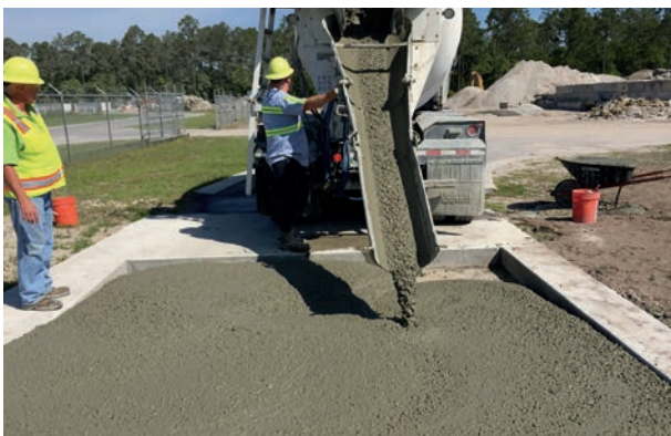
➤ Paso 6: Fabricación del panel de reemplazo con la mezcla SCC. No es necesario vibrar la mezcla.
