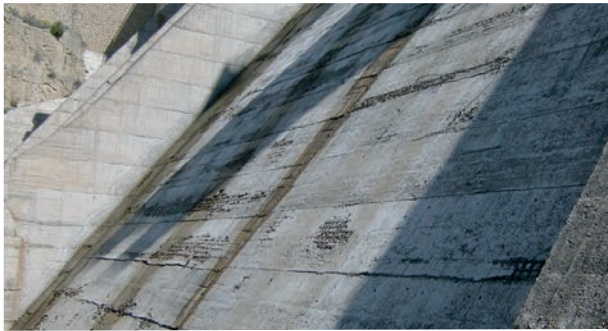
➤ Patología por ciclos de congelamiento y descongelamiento. Foto: © Eduardo Martínez Corregidor.
