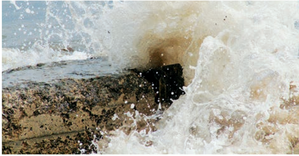
➤ Ataque de cloruros y sulfatos. Foto: Flickr- John Haslam
