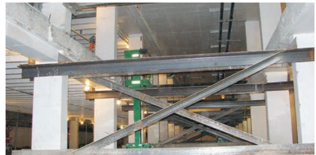
➤ Apuntalamiento y arriostramiento durante el remplazo de losas de concreto deterioradas. Foto: Cortesía Simpson Gumpertz and Heger
