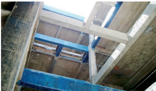
➤ Reforzamiento de vigas con materiales compuestos FRP. Foto: Cortesía BASF.
