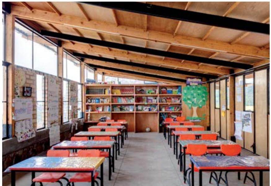
de adobe. Para la construcción de las techumbres se colocó una estructura de madera de la región soportada por bases de placas de acero en forma de U las cuales soportan las láminas galvanizadas.
