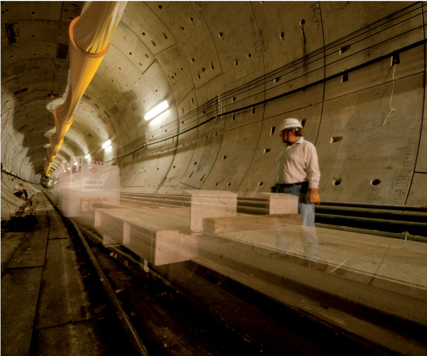
La tarea no era fácil para los expertos de la ingeniería mexicana. El reto principal, para la construcción del gran gigante de las profundidades, consistió en la fabricación de un concreto de alta resistencia a la compresión y al agrietamiento plástico, así como de altos revenimientos sin presentar segregación ni pérdida de revenimiento en un periodo de tiempo de al menos dos horas. Además del bombeo de concreto a través de más de 200 metros de tubería.
