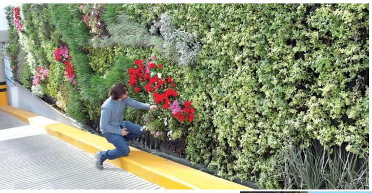
las raíces crecen en un medio artificial (estructura modular con concretos prefabricados y permeables). A decir de mucho verde, la aplicación de un sistema para un muro verde depende de las particularidades del espacio y su entorno. "Dependiendo del espacio a transformar en jardín vertical hemos prefabricado paneles verdes que se adosan a las edificaciones".
